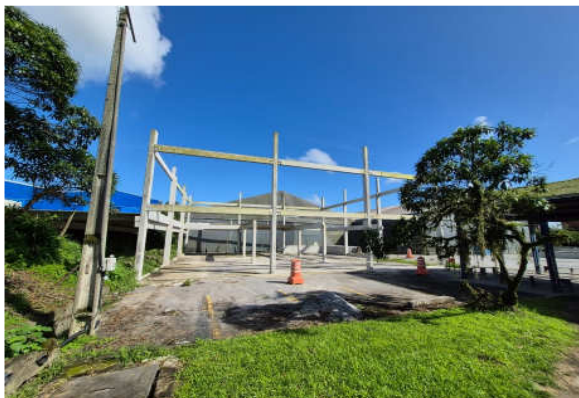
Futuro prédio administrativo.
