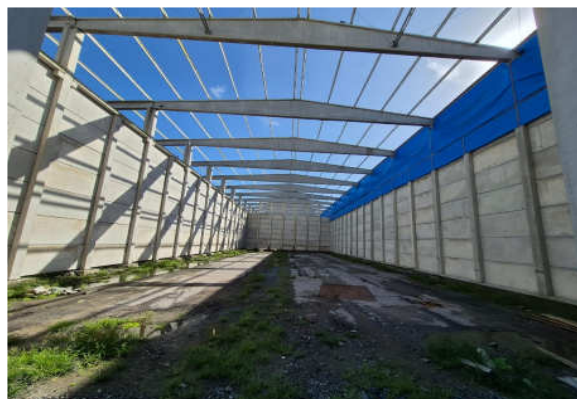
Vista interna - armazém.
