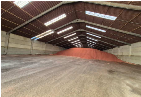
Vista interna - armazém.
