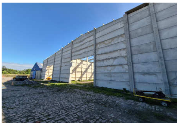
Vista externa - armazém granel (em construção).
