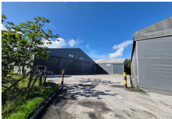
Armazéns de lona (provisórios).
