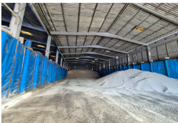
Vista interna - armazém.
