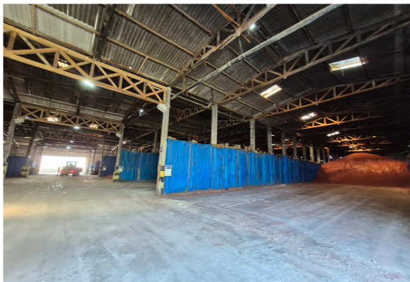
Vista interna - armazém.
