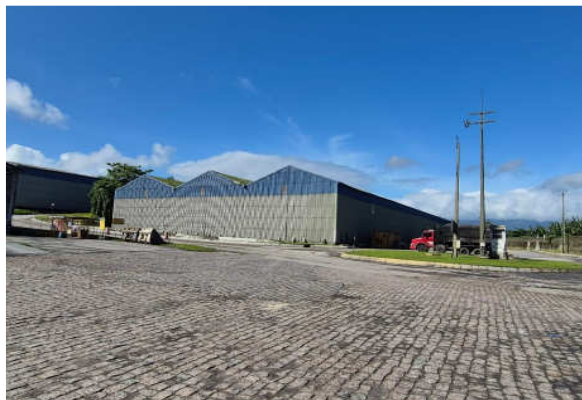
Vista externa - armazém granel.
