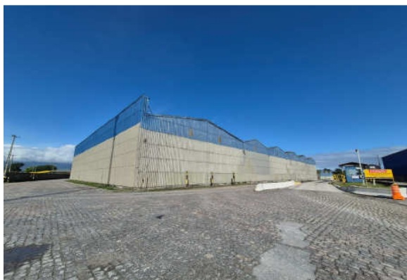
Vista externa - armazém granel.
