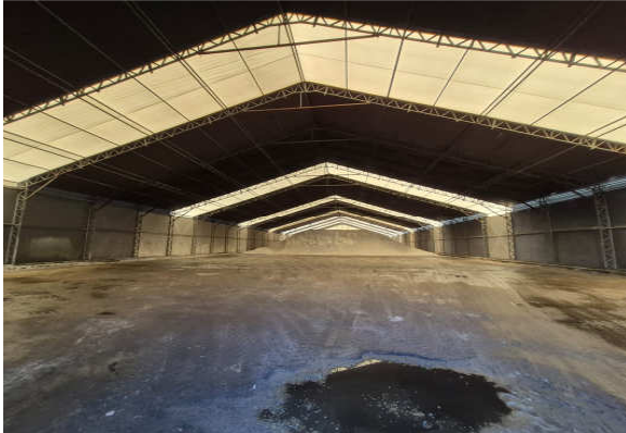
Vista interna - armazém.
