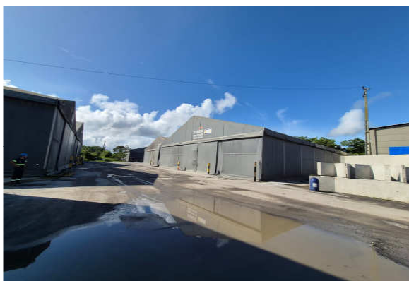
Armazéns de lona (provisórios).
