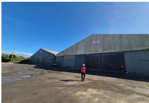
Armazéns de lona (provisórios).
