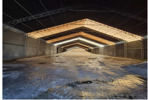
Vista interna - armazém.
