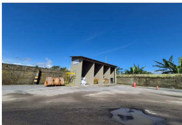
Central de resíduos.
