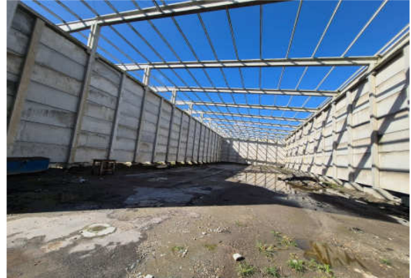
Vista interna - armazém.
