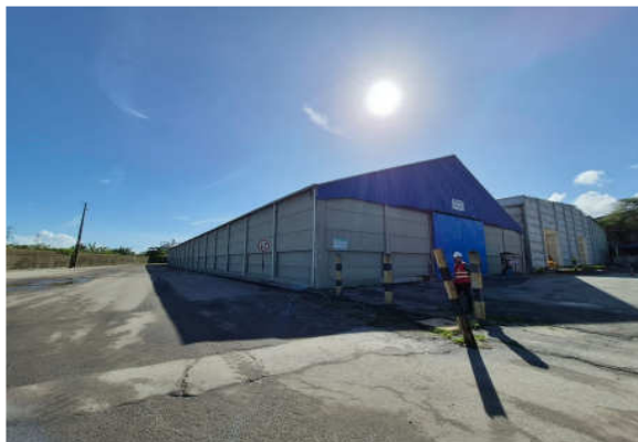
Vista externa - armazém granel.
