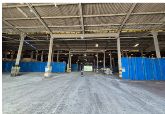
Vista interna - armazém.
