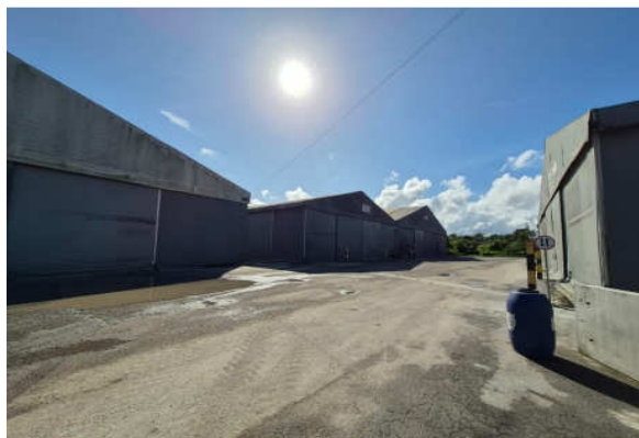
Armazéns de lona (provisórios).
