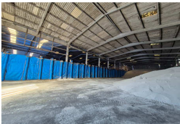
Vista interna - armazém.
