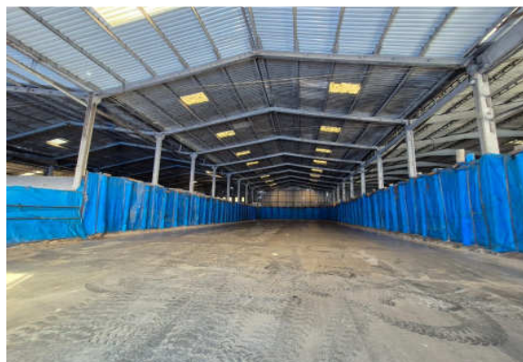
Vista interna - armazém.
