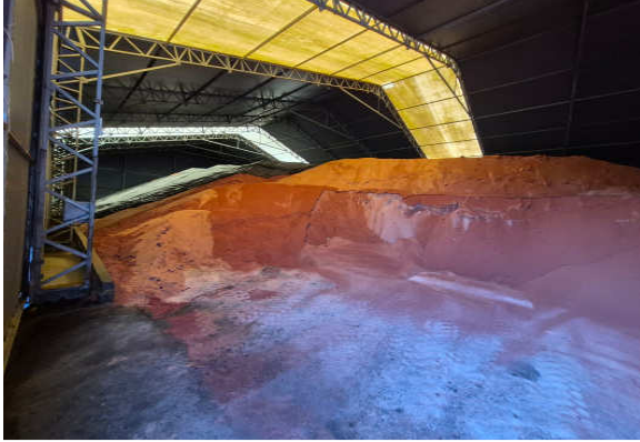
Vista interna - armazém.
